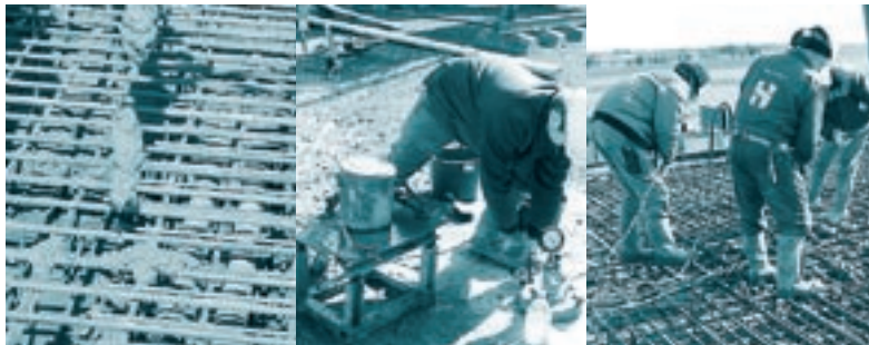
Fra opførelsen af den grønne demonstrationsbro. Billedet i midten viser modtagekontrol af beton på byggepladsen, idet det måles, at betonens luftindhold er i orden.
